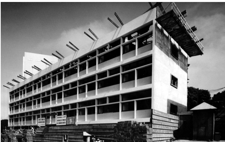
Obras de construção do novo edifício dos "Seminários Livres de Música da Universidade da Bahia" - 1961/62
